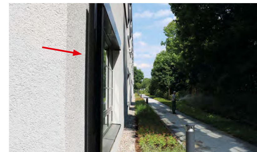
Lichtschranke zur Fassadenüberwachung
